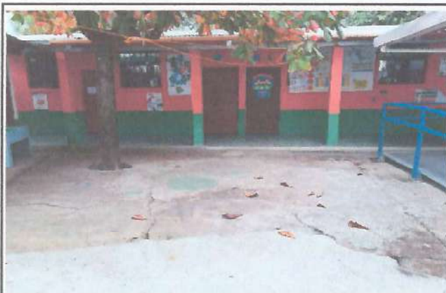
Foto 3: Mejoramiento de área de patio
