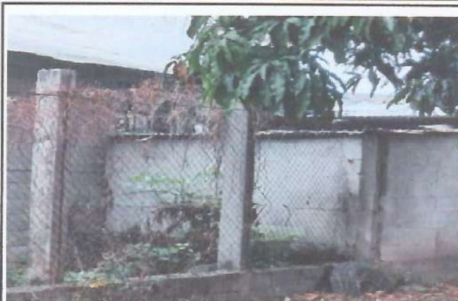
Foto 2: Mejoramiento de muro perimetral
