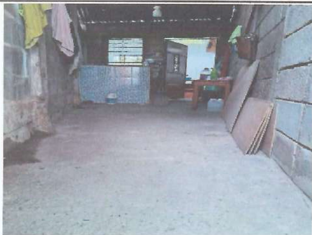
Foto1: Mejoramiento de área de Cocina
